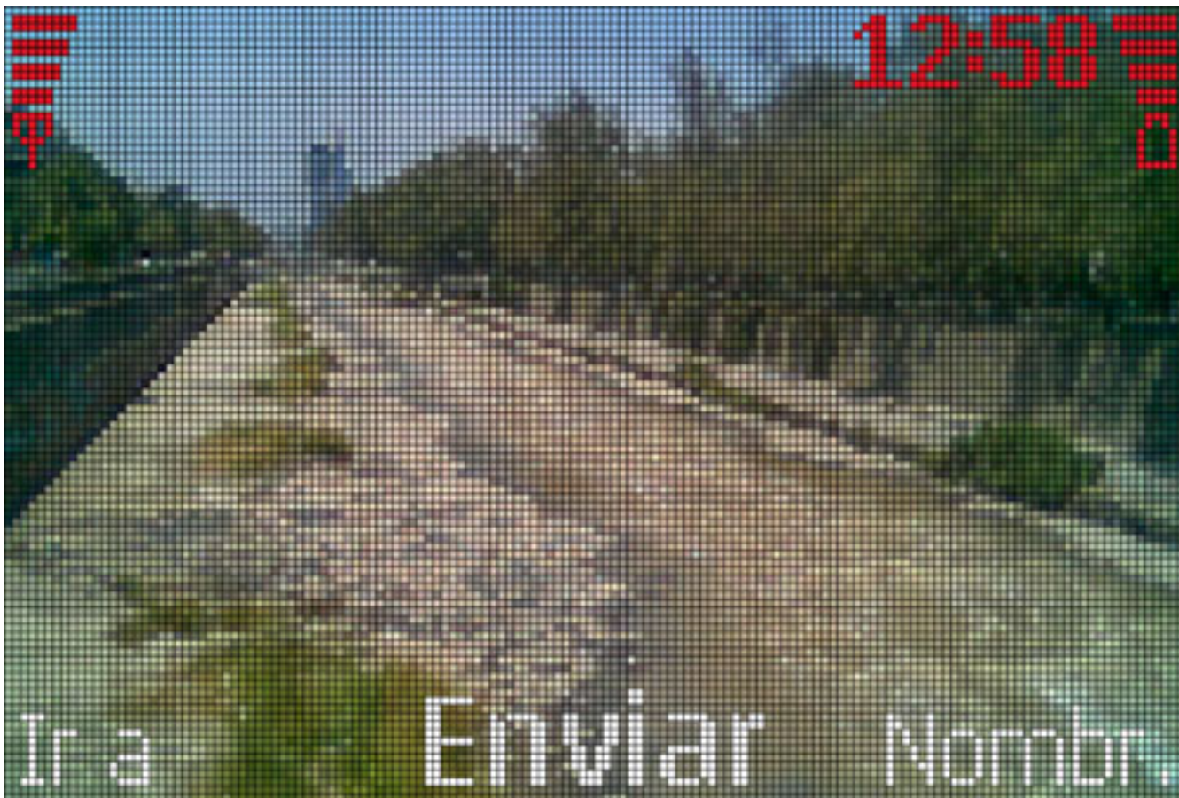
MIRA DONDE ESTOY (detalle de instalación)
